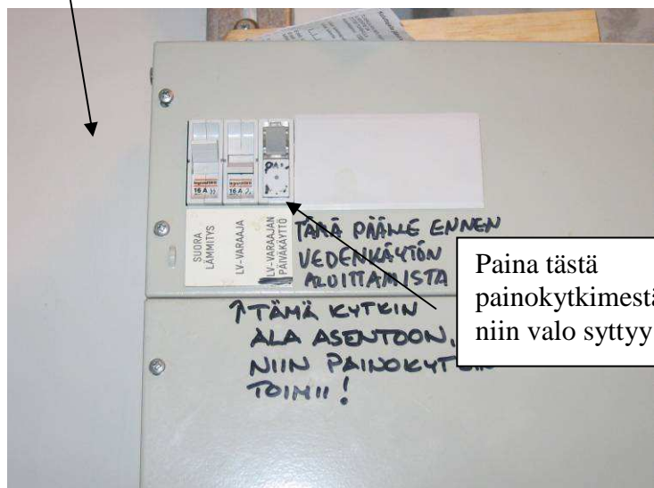
Kuva 2. Lämminvesivaraajan kyt- keminen päiväsähkölle
